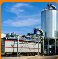
Truck Loading System – nowoczesna logistyka materiałów sypkich
